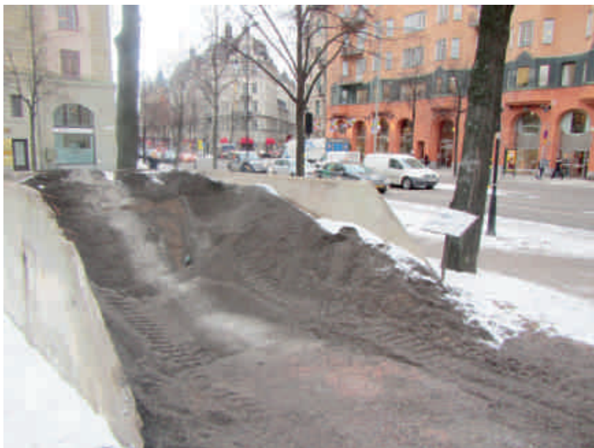
Sandfickor som placerats strategiskt ger utföraren snabb tillgång till halkbekämpningsmaterialet. Korta transport- och ställtider ger en effektivare halkbekämpning. Foto: Peter Sandberg.
