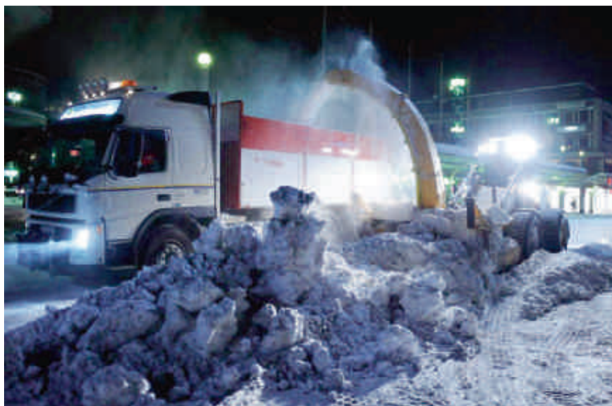
Ny och effektivare teknik är en av metoderna att minska borttransporten av snö. I Norrlandsexemplet har man numera en snöslunga i vinterdriften. Foto: Lars Petterson.
