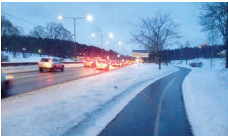
En cykelbana där sopsaltningen används i Stockholms stad under vintern 2013. Ytan är svart, trots snö runt omkring. Foto: Stockholms stad
