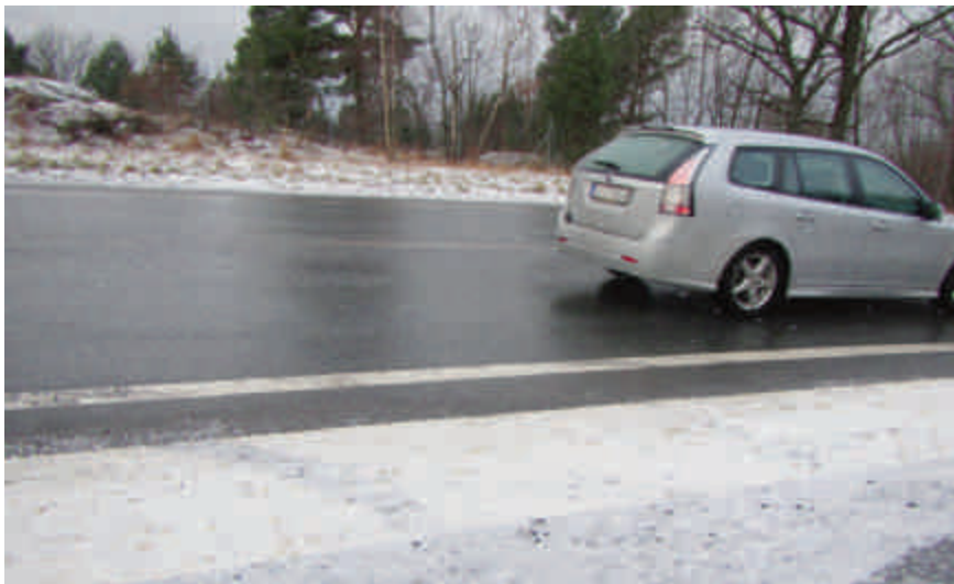
Exempel på förebyggande halkbekämpning med bra resultat. Snöfallet pågår men snön får inte fäste i vägbanan. Foto: Peter Sandberg.
