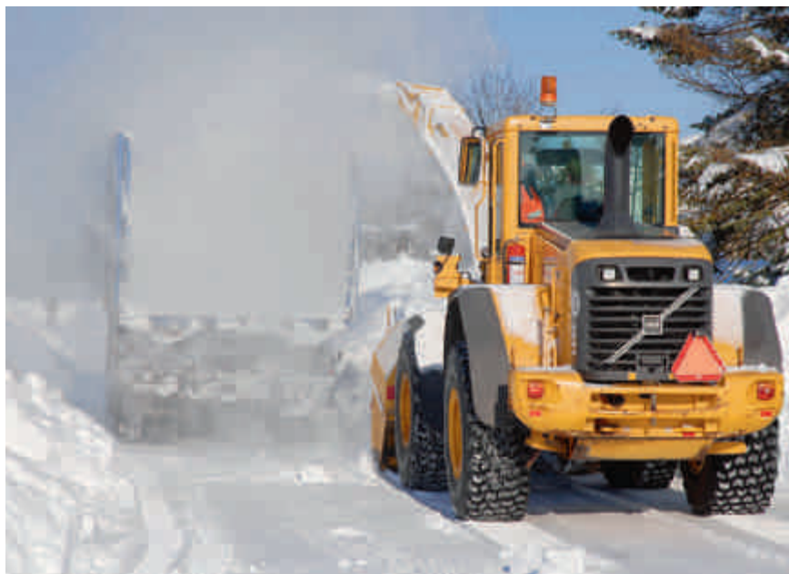
Effektiv snöbortforsling och breddning av vägen med traktor och snöslunga. Foto: Mellerud
