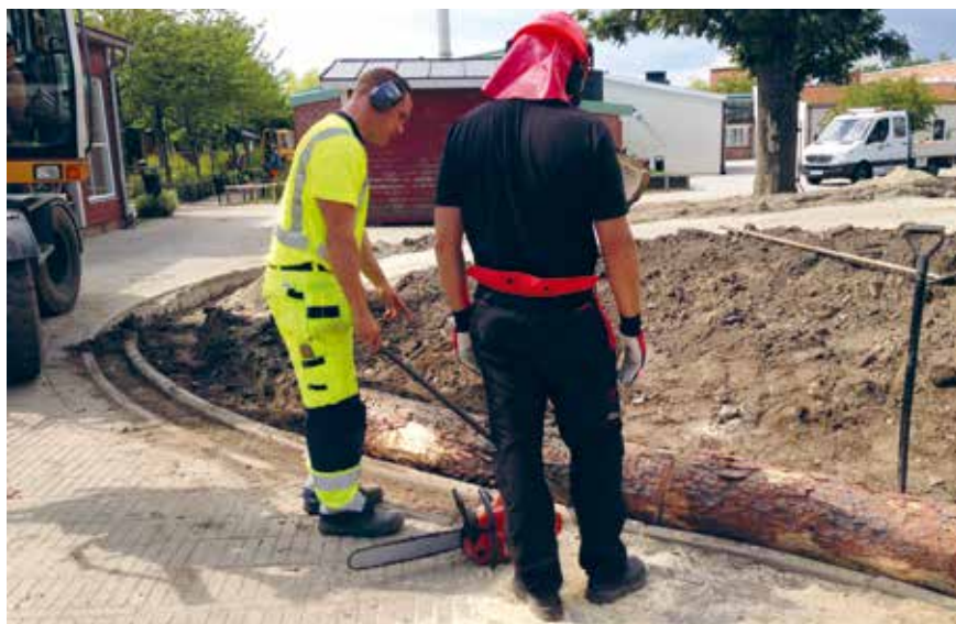
Barnens förslag om terrassodling på skolgården medförde nya utmaningar i anläggningsarbetet när tallstockar barnen varit med om att fälla användes som sarg.
