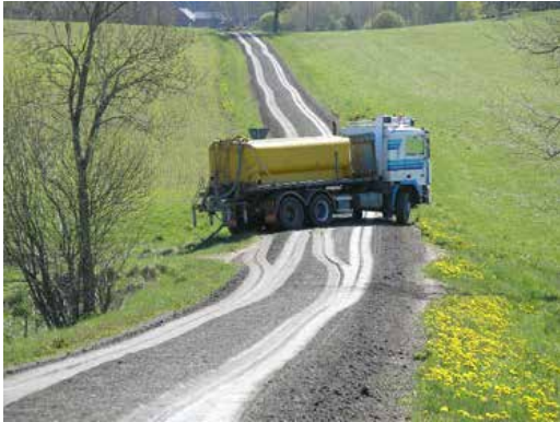
Lastbil med vattencistern för vattning av grusvägen. Vattnet sprayas ut genom de fyra dysorna på spridarrampen längst bak. Vatten tas med fördel från närbelägen naturlig vattenkälla för att undvika onödig transport. Foto: Karin Edvardsson.
