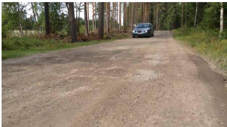
Potthålsformade hål i körbanan. Foto Karin Edvardsson.
