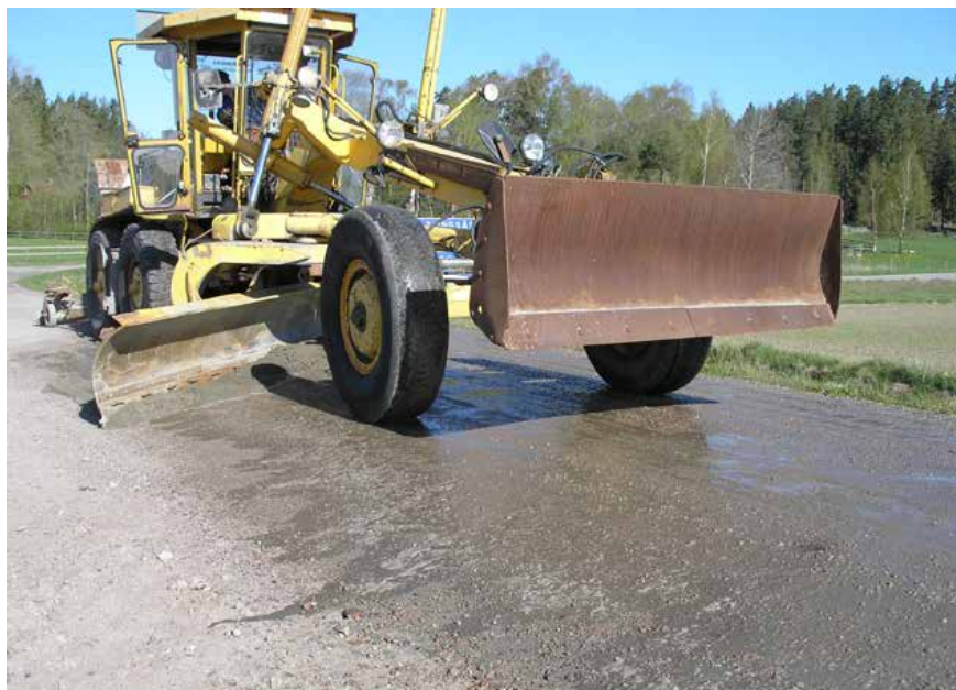
Väghyvel i arbete. Foto: Karin Edvardsson.
