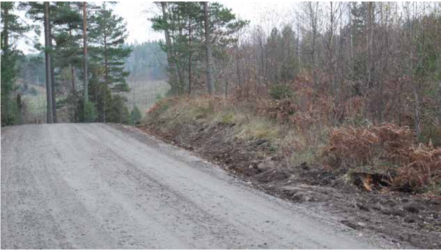
Otillräcklig dikning. Fotograf Leif Kronkvist, Riksförbundet Enskilda Vägar.
