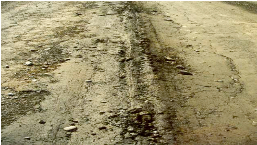
Tjälskott är flytjordmassor som kommer upp genom sprickor i den redan upptorkade vägbanan. Foto: Väg- och Transport-forskningsinstitutet.
