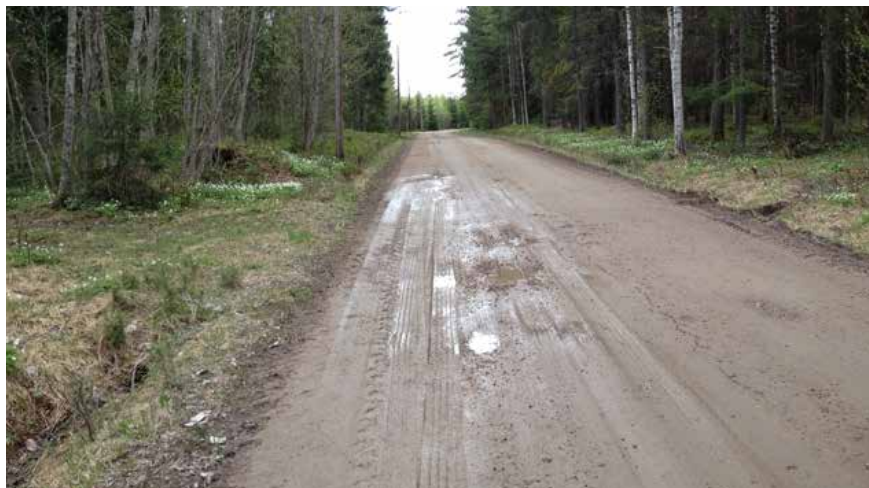
Ytuppmjukning leder till kraftig nedsmutsning och framkomlighetsproblem. Foto: Karin Edvardsson.
